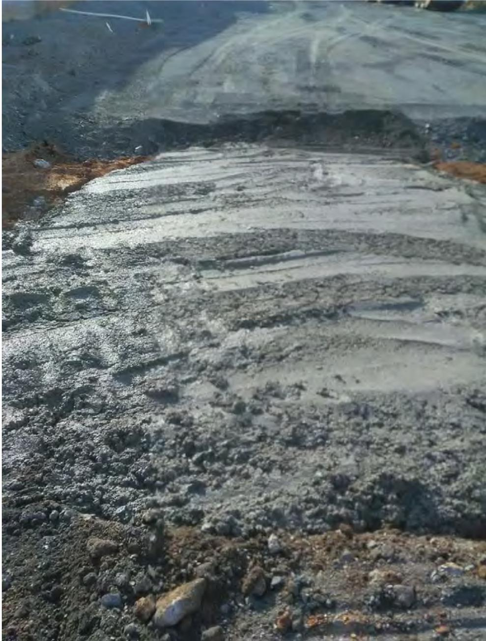
Foto 2.9 – Pozzetto in c.a. interferente: dettaglio riempimento con cls.
