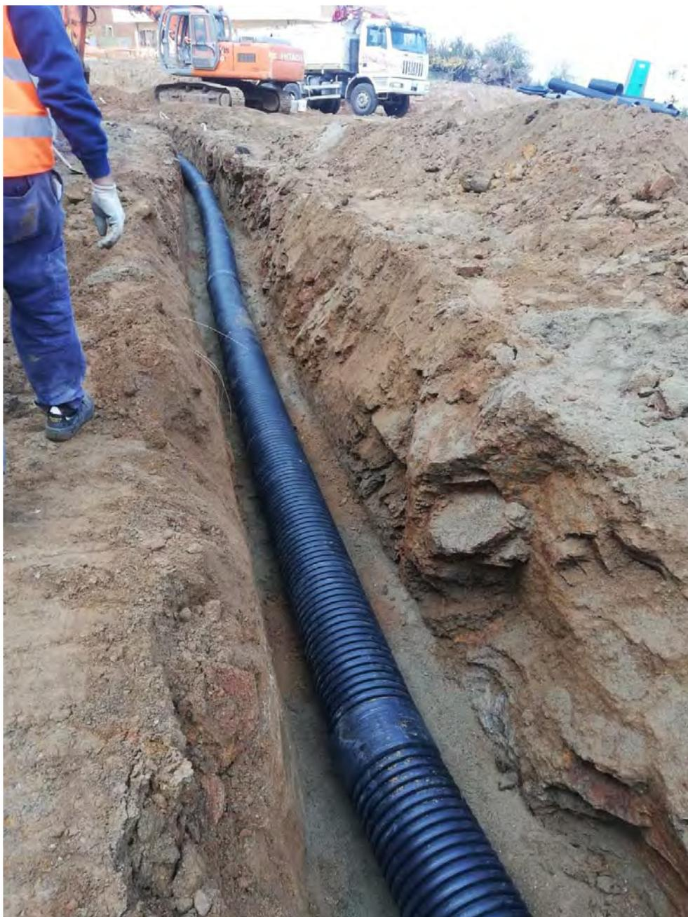
Foto 1.3 – Ulteriore condotta di deflusso: posa tubazione diametro interno 300 mm.
