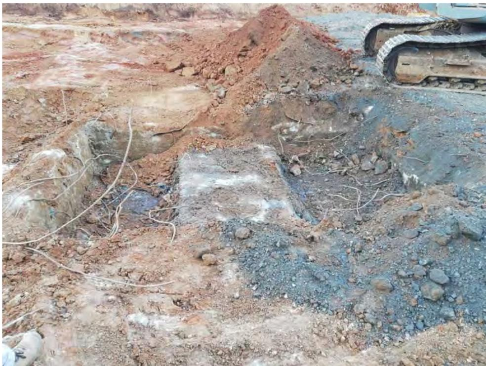
Foto 2.5 – Pozzetto in c.a. interferente: dettaglio interno da riempire con cls.
