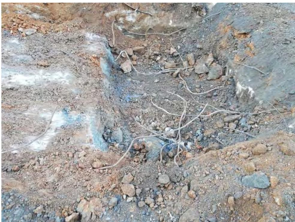
Foto 2.6 – Pozzetto in c.a. interferente: dettaglio interno da riempire con cls.
