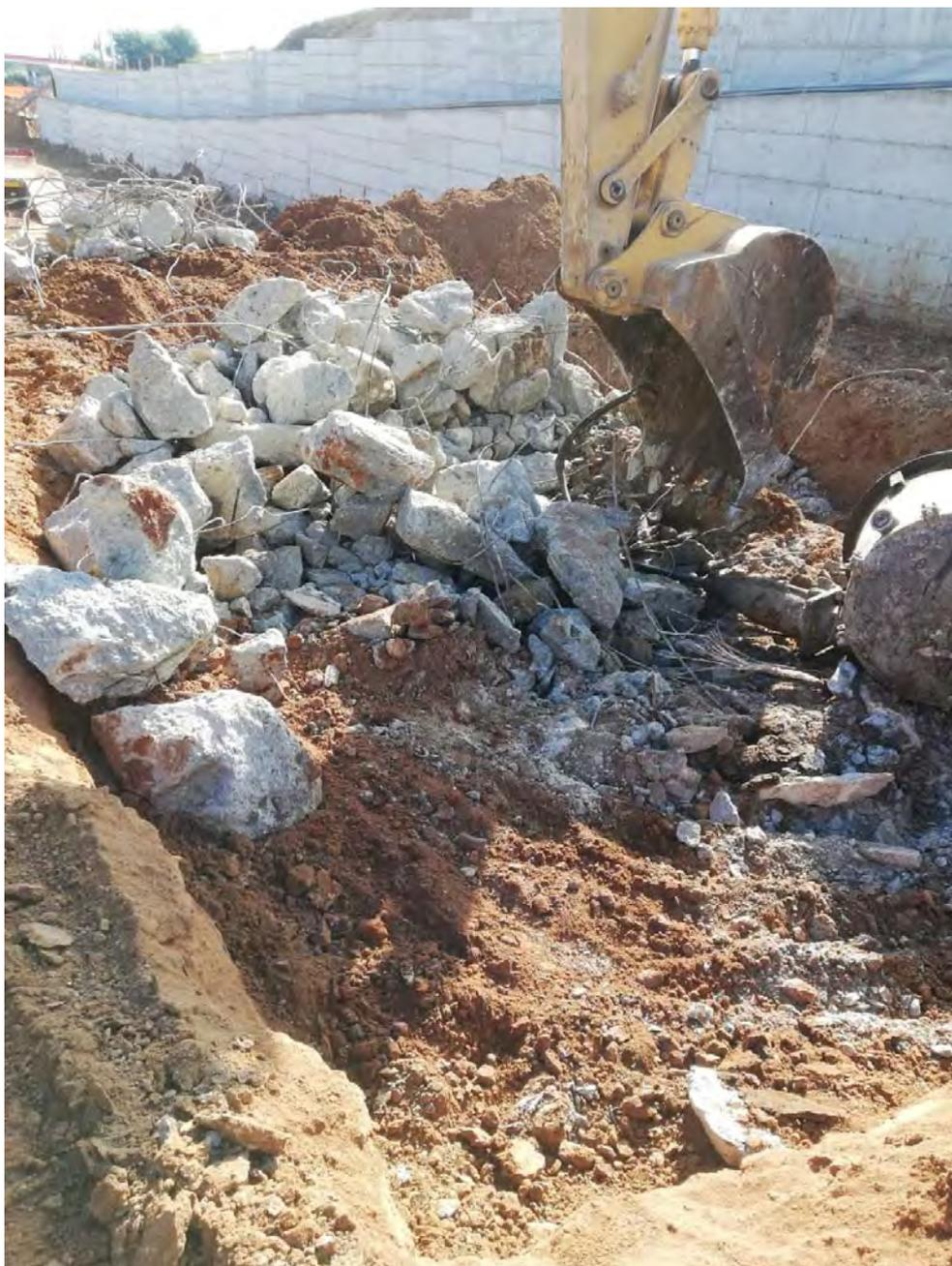
Foto 2.4 – Demolizione pozzetto in c.a. interferente.
