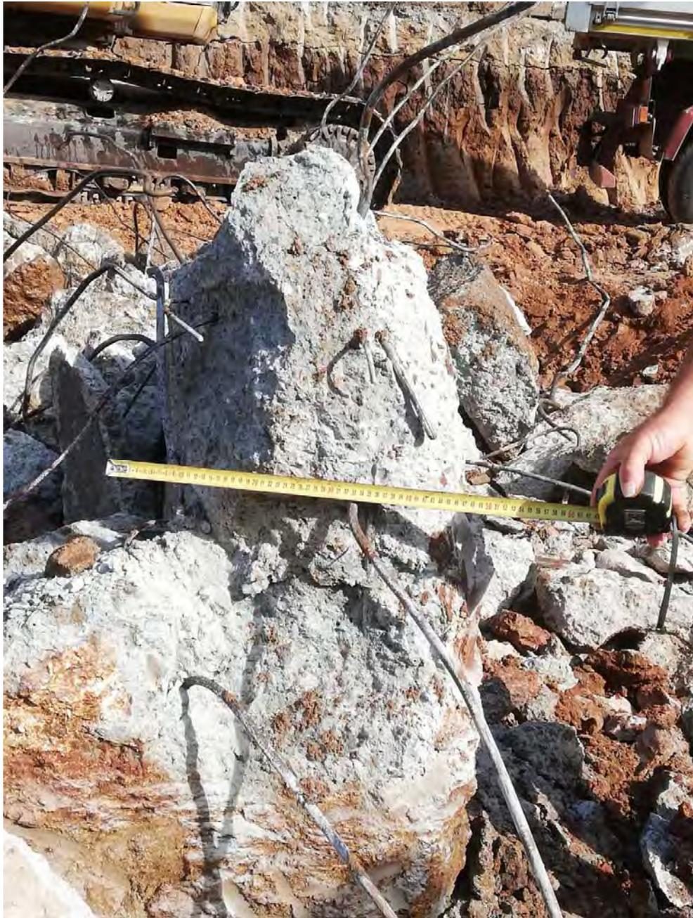
Foto 2.7 – Pozzetto in c.a. interferente: dettaglio misurazione spessore pareti.
