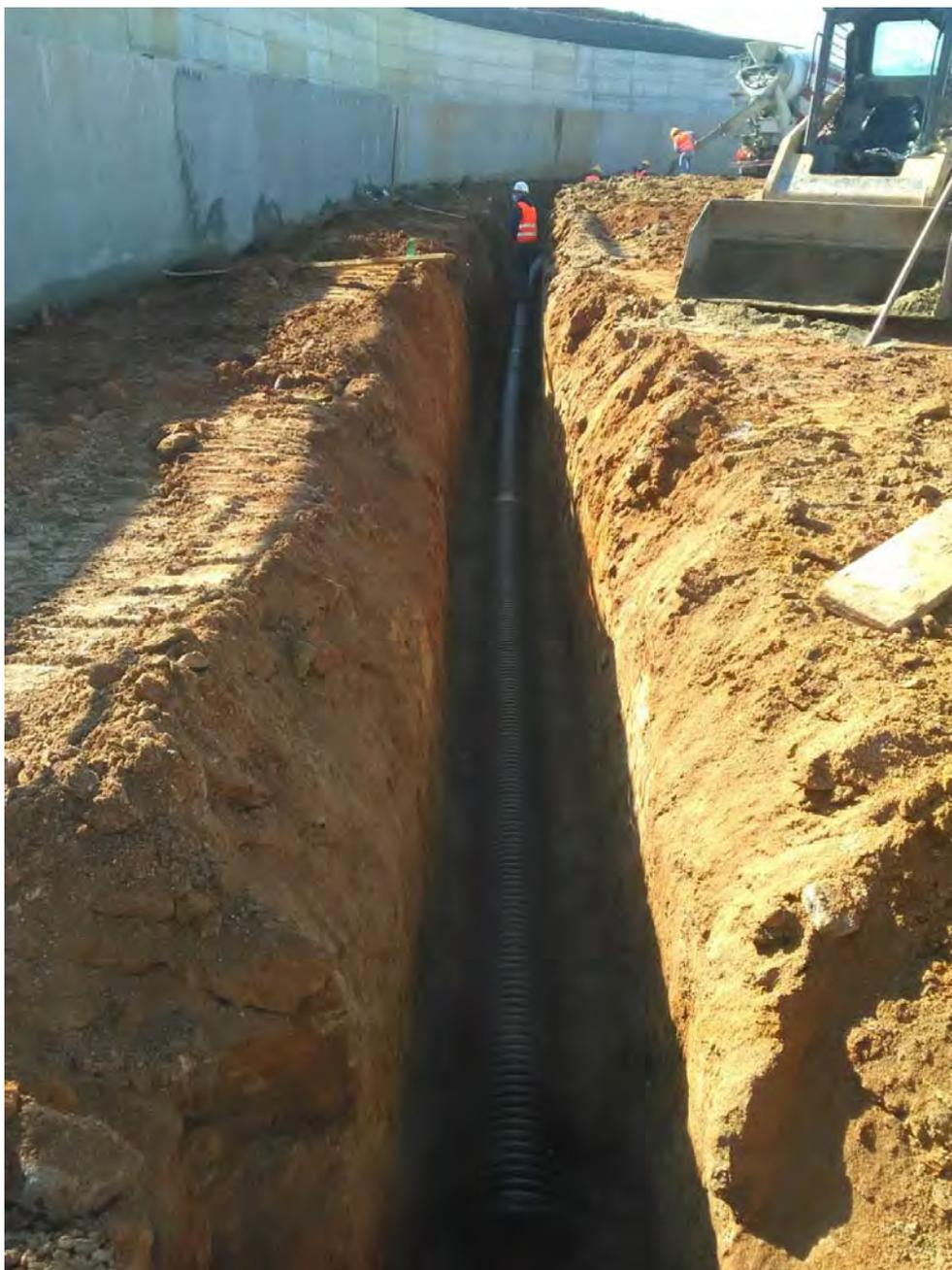
Foto 1.4 – Ulteriore condotta di deflusso: posa tubazione diametro interno 300 mm.
