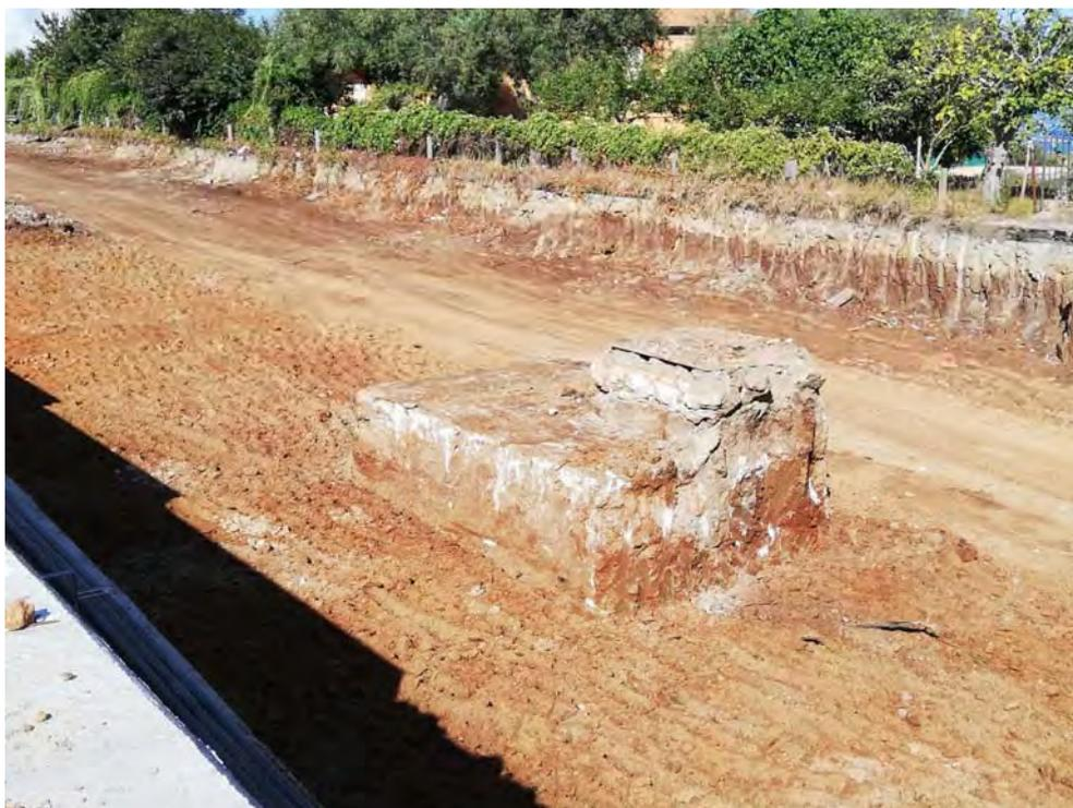
**Foto 2.2 – Pozzetto in c.a. interferente.**
