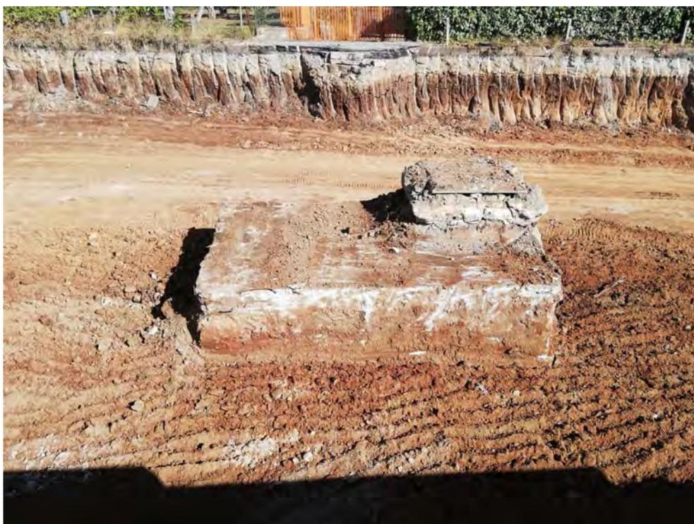
Foto 2.1 – Pozzetto in c.a. interferente.
