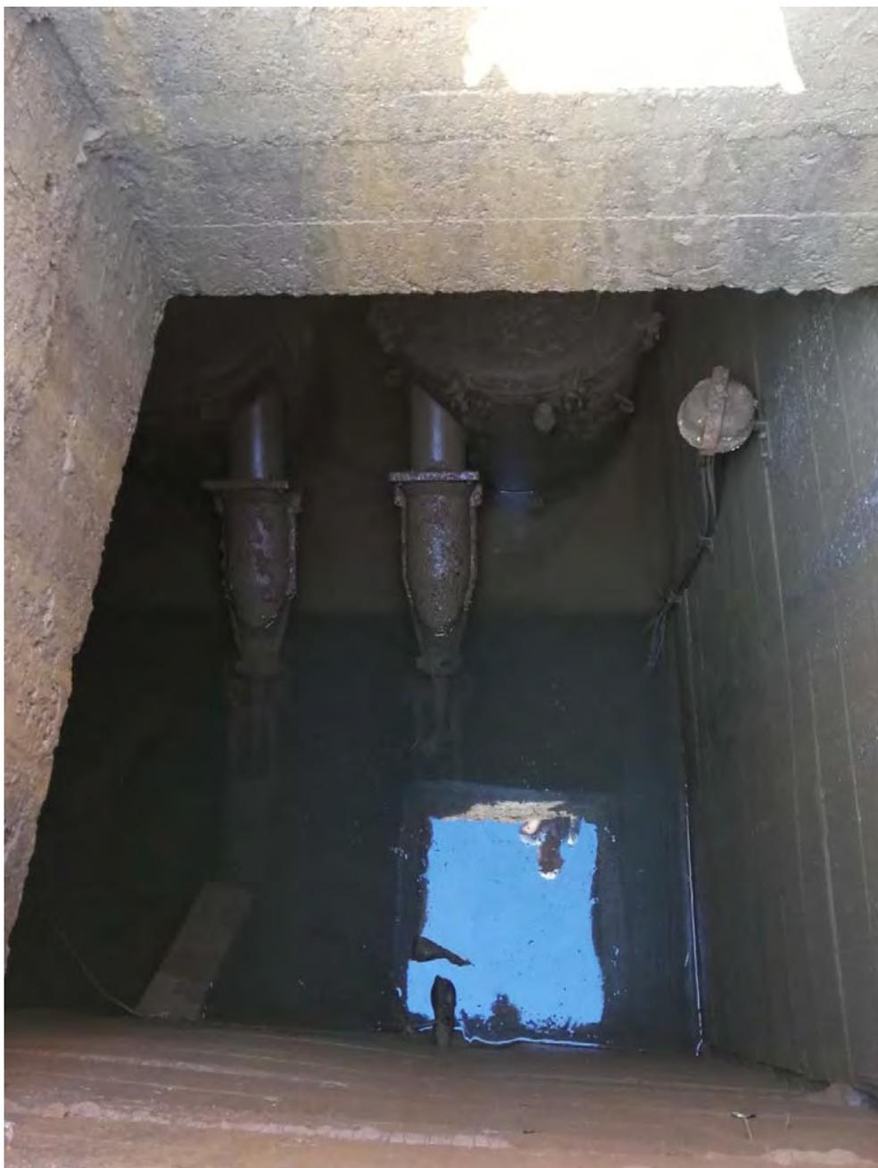
Foto 2.3 – Pozzetto in c.a. interferente: dettaglio vista interno.
