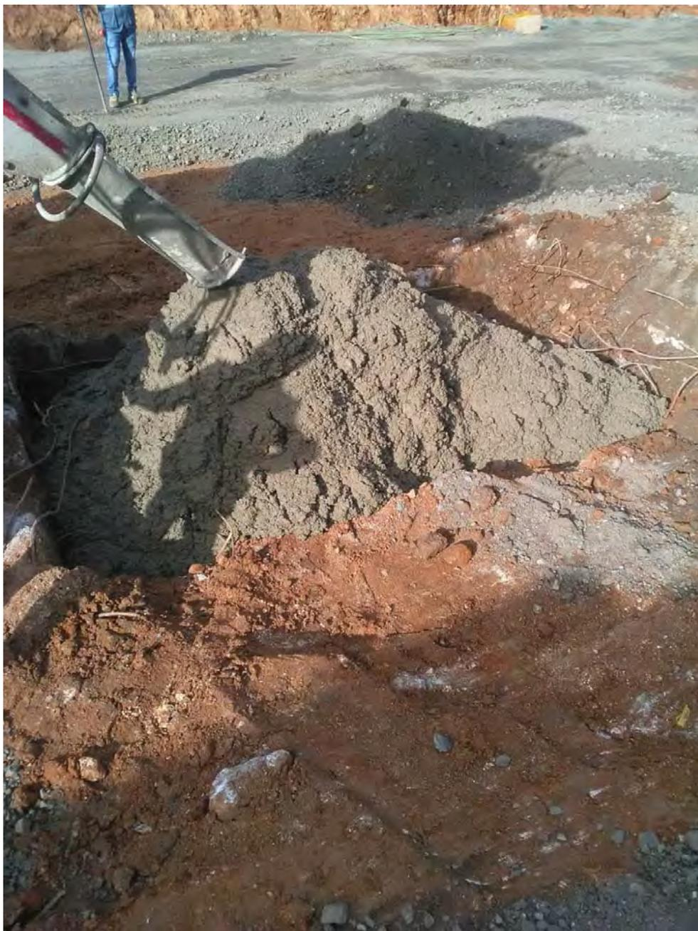
Foto 2.8 – Pozzetto in c.a. interferente: dettaglio riempimento con cls.
