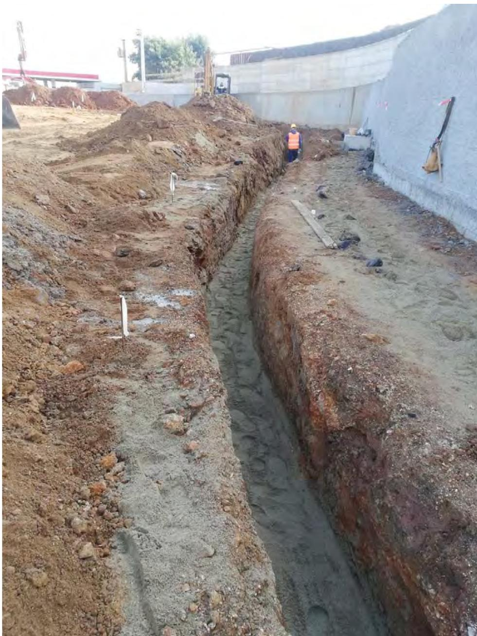
Foto 1.2 – Ulteriore condotta di deflusso: scavo per posa tubazione.
