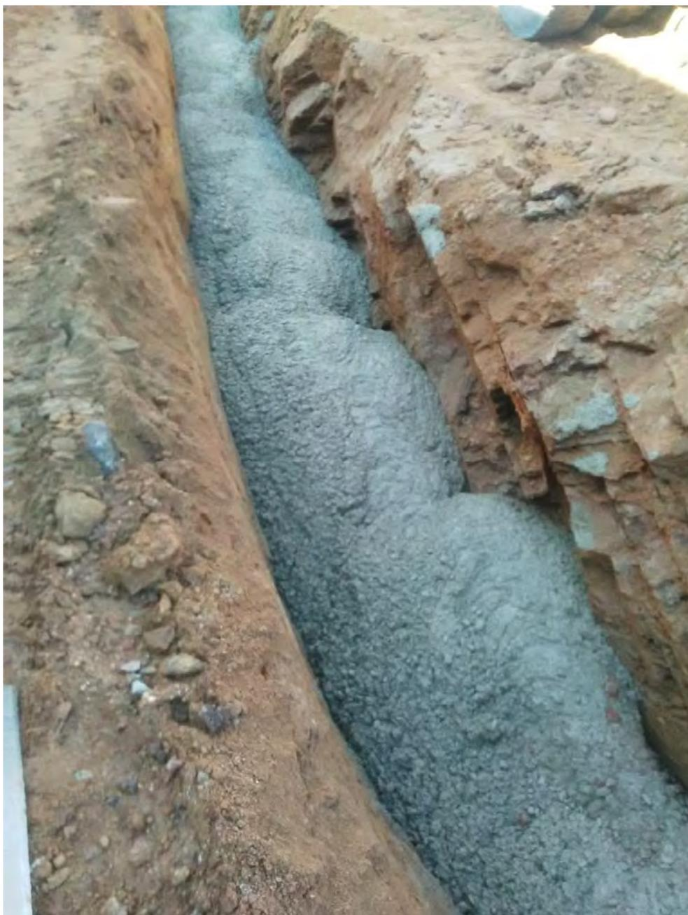
Foto 1.5 – Ulteriore condotta di deflusso: calottamento con cls della tubazione.
